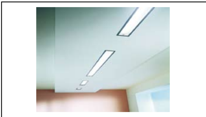
Gipskarton-Kasten mit Auslässen
