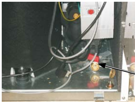
Füll- und Entleerhahn Solekreis
