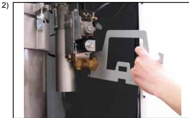
Verschraubung Gasanschluss am Gaskombiventil lösen
