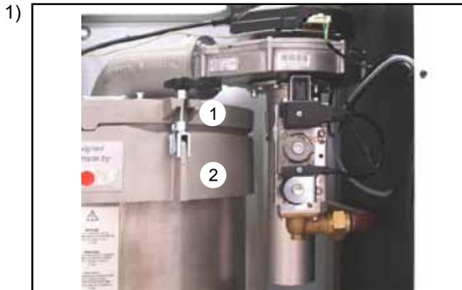
Stecker ①② abziehen (vorher Kreuzschlitzschrauben lösen)
