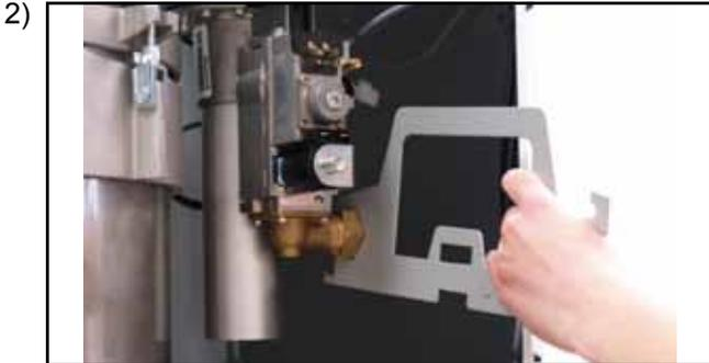
2) Verschraubung Gasanschluss am Gaskombiventil lösen
